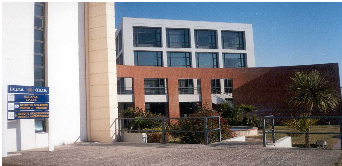
Εικόνα Error! Unknown switch argument.: Κτίριο Διοίκησης Ε.Κ.Ε.Τ.Α
